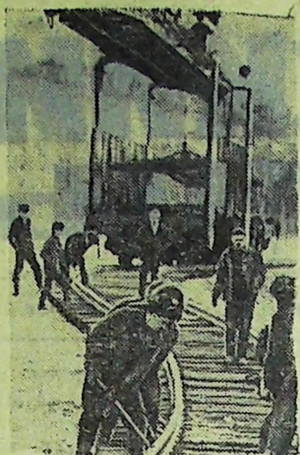
Коллектив управления «Бамстройпуть» взял обязательство досрочно закончить строительство и открыть рабочее движение на участке БАМ—Тында. На снимке: монтаж пути на 162 километре. Фото Г. Калачяна (Фотохроника ТАСС).
