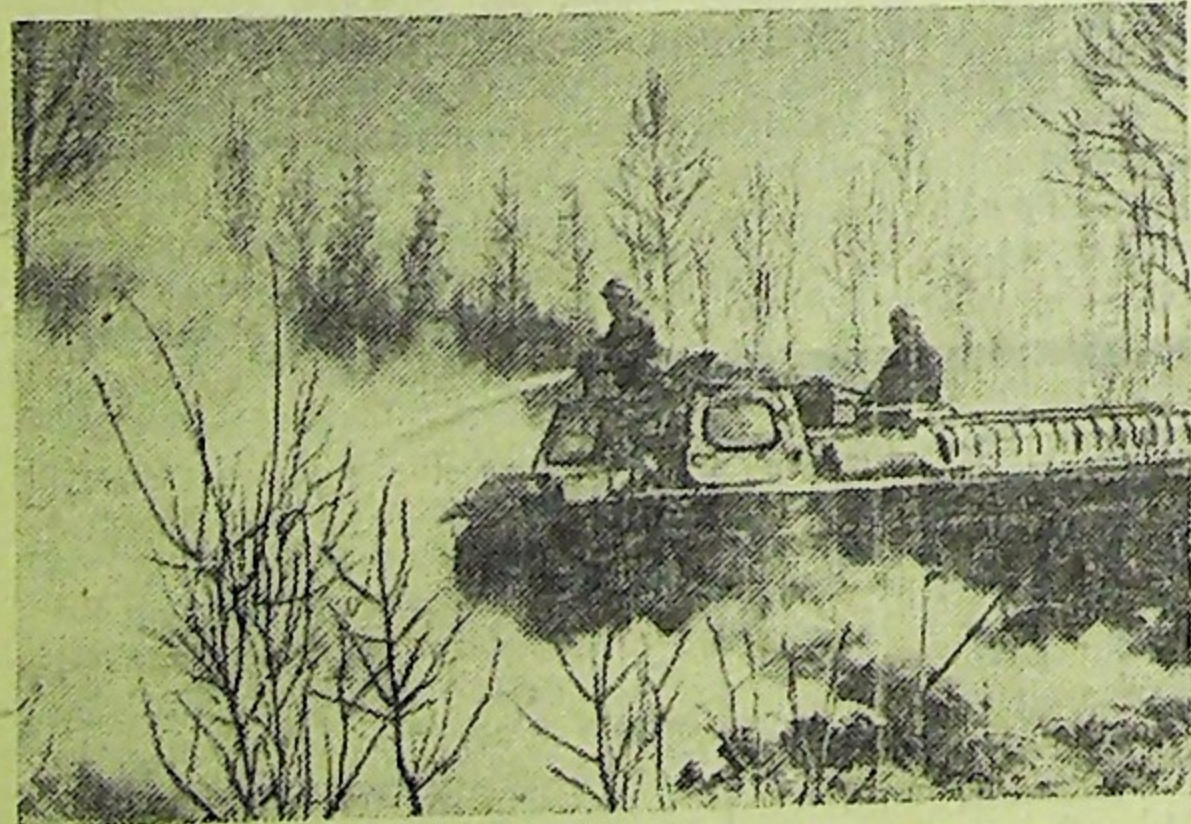
Хабаровский край. В Дальневосточном научно-исследовательском институте лесного хозяйства сконструирован пожарный вездеход ВП-1. Смонтированное на нем оборудование позволяет вести борьбу с огнем на расстоянии 10-15 метров. тушить верхушки деревьев.
