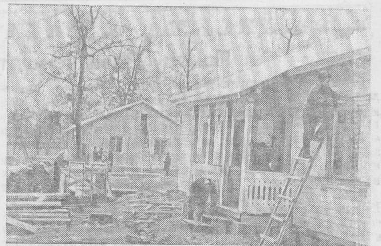
Волынская область В Киверцовской МТС выстроены типовая мастерская, здание конторы и десять домов для механизаторов. На снимке: строительство домов в Киверцовской МТС. Фото А. Платонова Прессклише ТАСС.
