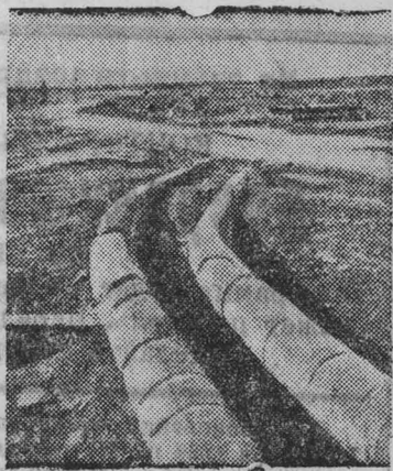
Английские нефтепроводы, проложенные из Ирака в Хайфу через Сирию.
