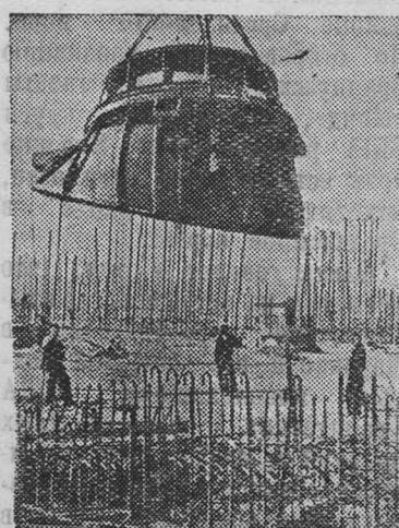
**Волгодонстрой.** С каждым днем все выше поднимаются железобетонные сооружения Волго-Донского соединительного канала. Монтажники водонапорной станции Карповского водохранилища, борясь за досрочное завершение работ, решили вести монтаж мощных насосных агрегатов одновременно с бетонными работами.
