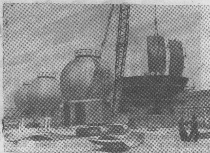
**Азербайджанская ССР.** На строительстве бутановой группы цехов Сумгайтского завода синтетического каучука сооружаются шаровые ёмкости. Каждый стальной шар монтируется из отдельных сегментов. Эту сложную работу выполняет бригада монтажников участка «Стальконструкций», возглавляемая Иваном Решетовым. Ее коллектив, внедривший в производство несколько рационализаторских предложений, выполняет нормы на 150 процентов.
