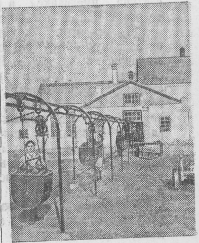
Днепропетровская область. Животноводческий совхоз «Заря» в нынешнем году построил несколько производственных и жилых помещений. Недавно вступил в строй новый кормоцех, где ежедневно будет готовиться 25 тонн кормов. Все процессы приготовления кормов механизированы. От кормоцеха проведена подвесная дорога, по которой готовые корма доставляются в свиноводческие фермы. На снимке: у нового кормоцеха в совхозе «Заря».
