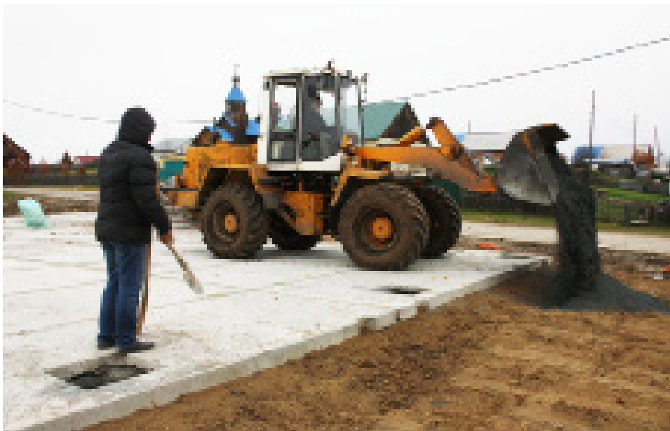
В Горках подрядная организация приступила к закладке фундамента под будущее здание пожарного депо
